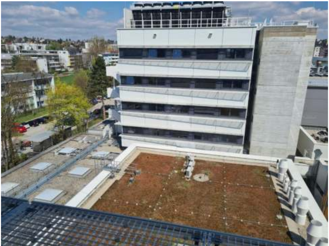
Figura 15. Terasă cu vegetație scundă dezvoltată pe terasa unei clădiri, ce contribuie în mod substanțial la diversificarea nișelor ecologice de la nivelul zonei
