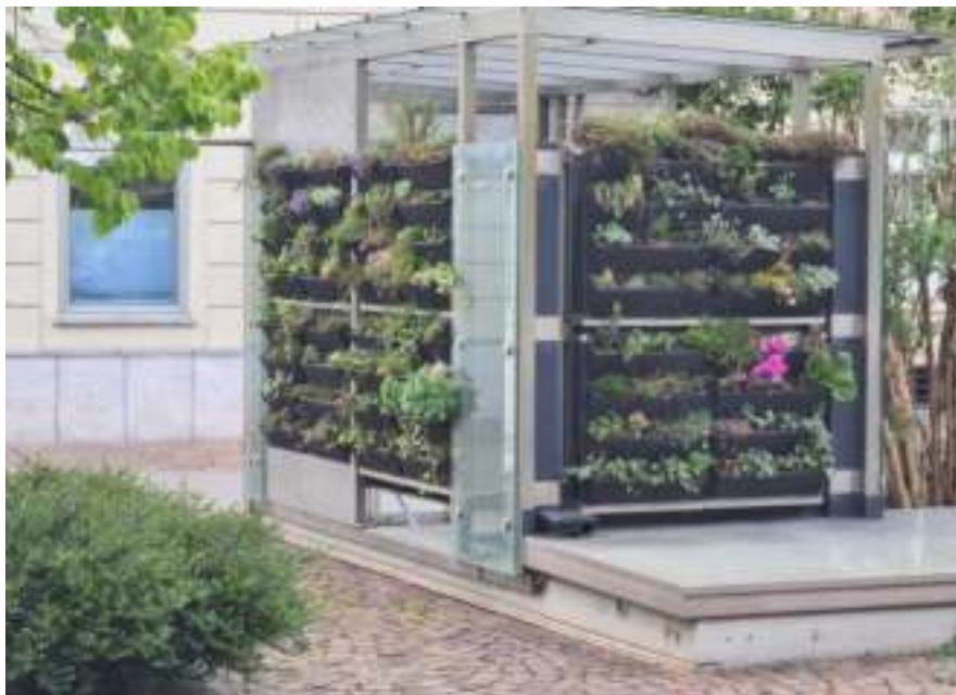
Figura 14. Grădină verticală ce maschează un element construit și contribuie la o integrare armonioasă în peisaj, având un rol ecologic și estetic înalt
