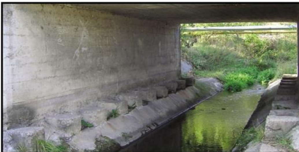
Fig. 27. Pod cu bermă intermediară, favorabil.
