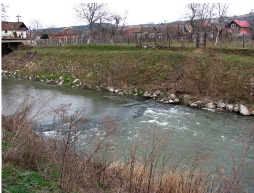
Fig. 13. Prag de fund executat din anrocamente de piatră, fără utilizare de beton care asigură libera migrație a speciilor de pești.
