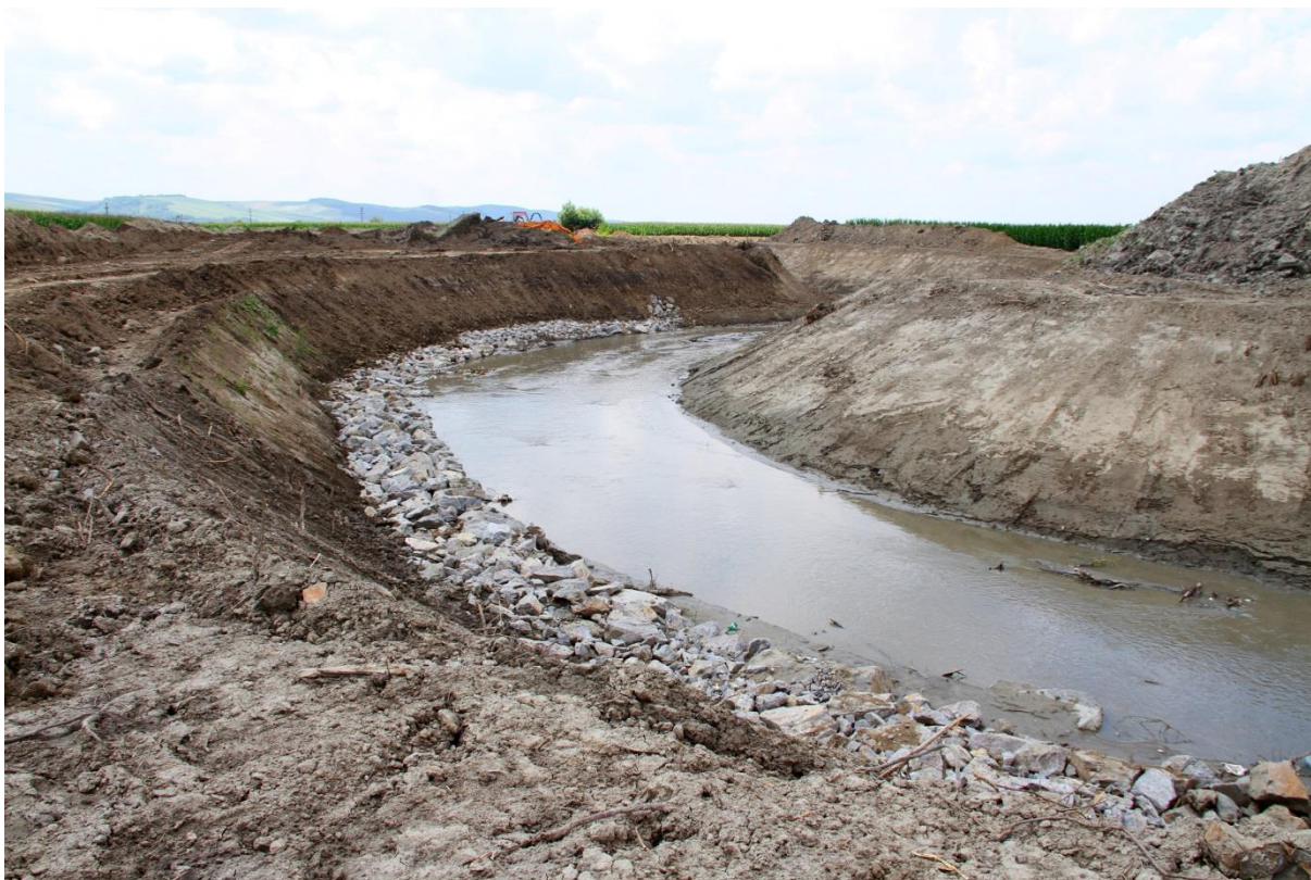
Fig. 16. Îndepărtarea vegetației de pe malul unui râu în timpul executării unor lucrări de prevenire a inundației în 2015.
