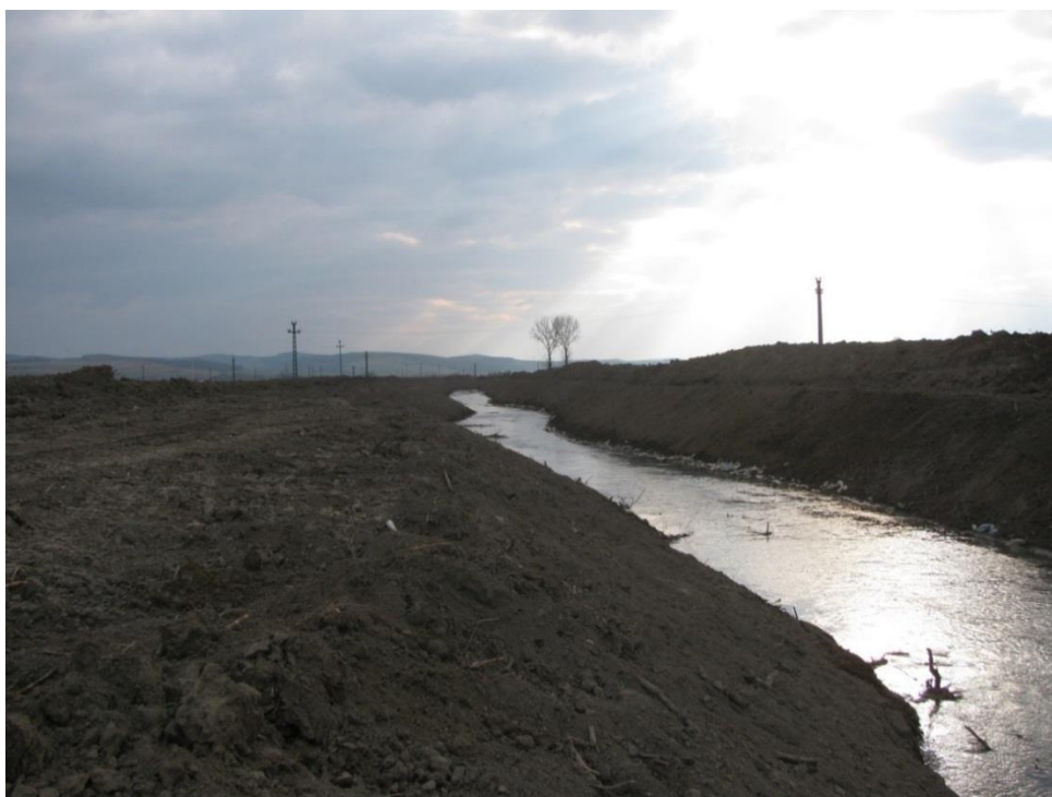
Fig. 22. Efectuarea lucrărilor pe ambele maluri ale râului afectează grav biodiversitatea zonei.
