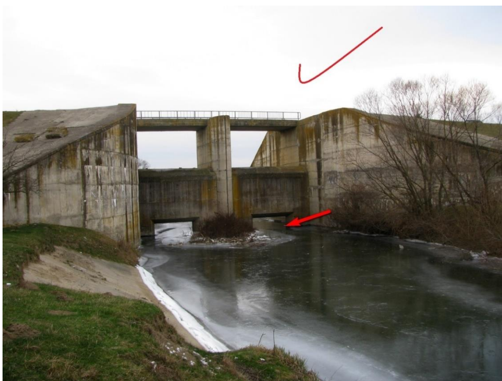
Fig. 19. Exemplu bun: Barajul acumulării nepermanente de pe Târnavă Mică de la Bălăușeri: există conectivitate la nivelul talvegului.
