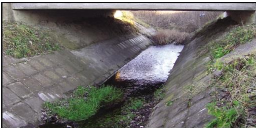
Fig. 26. Pod fără bermă intermediară, nefavorabil.
