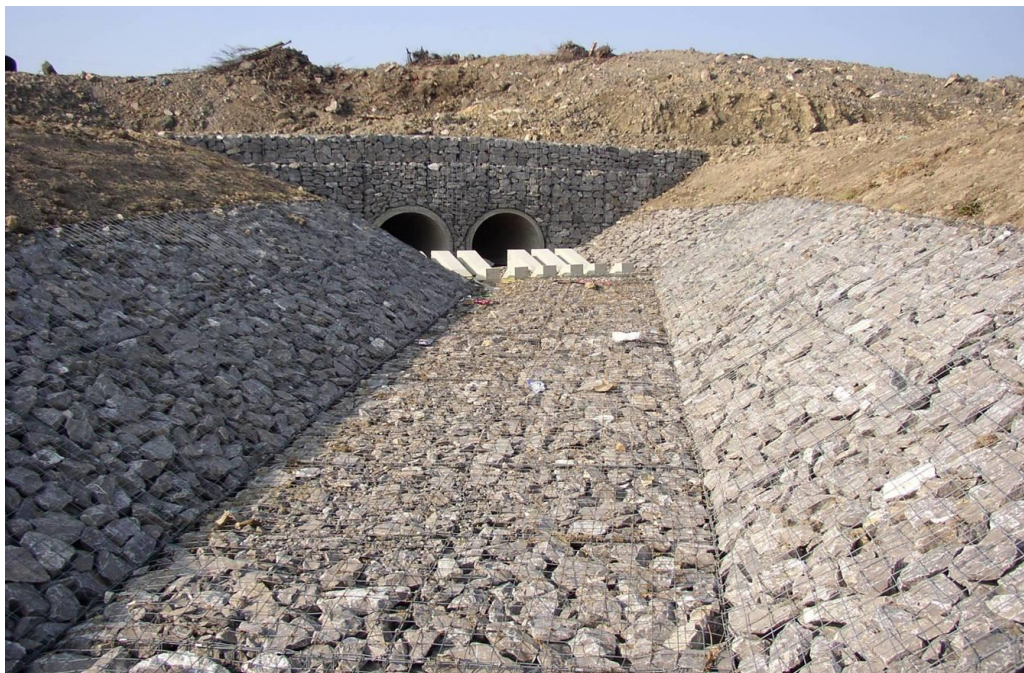
Fig. 25. Pod cu gabioane nefavorabil.
