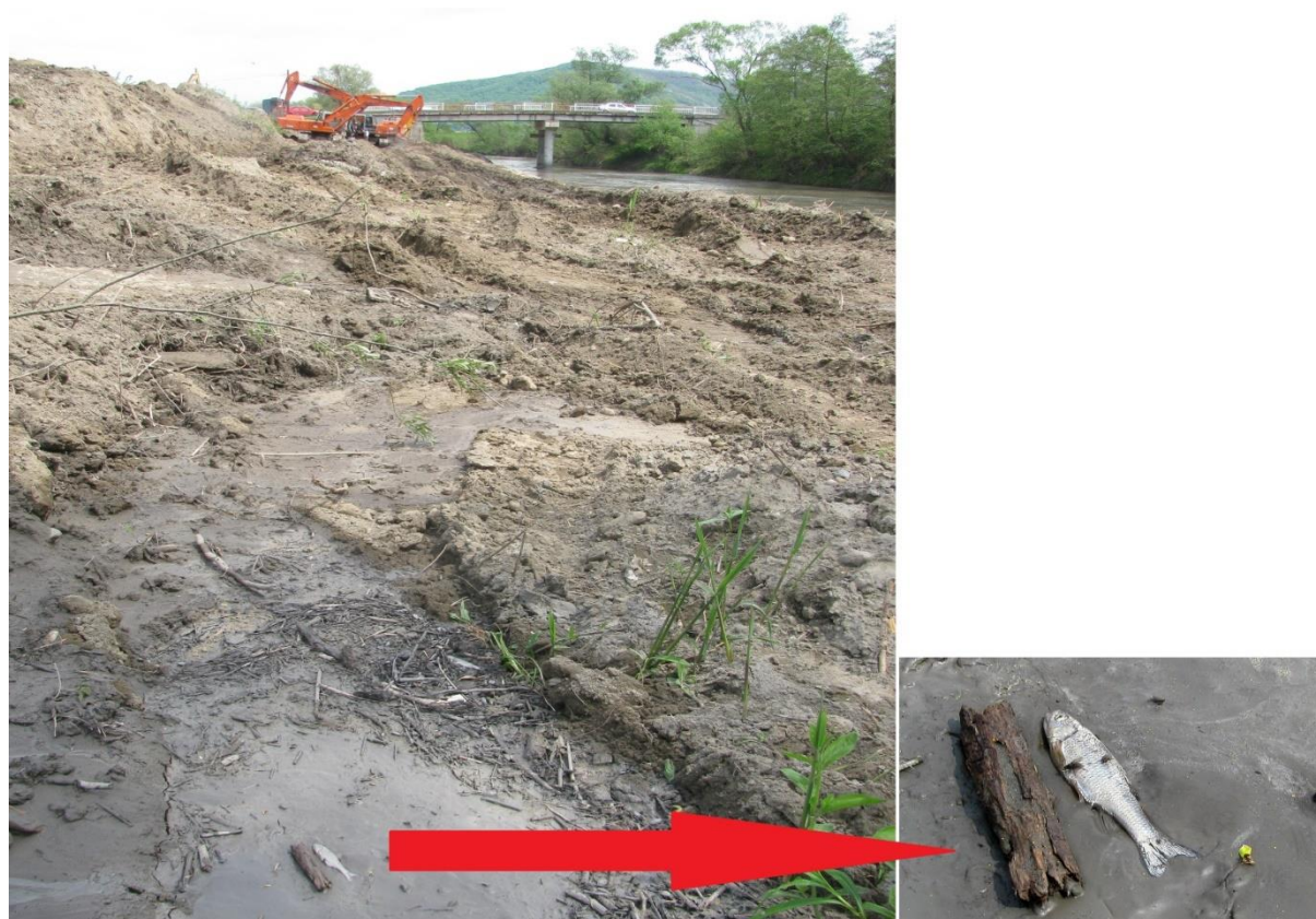
Fig. 12. Pește mort din cauza decolmatărilor în timpul execuției unor lucrări de prevenire a inundațiilor.
