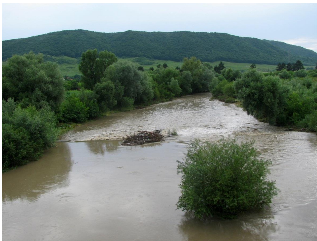
Fig. nr. 16: Prag din beton cu scară de pești nefuncțională pe râul Bistrița în apropiere de confluența acestuia cu râul Șieu.
