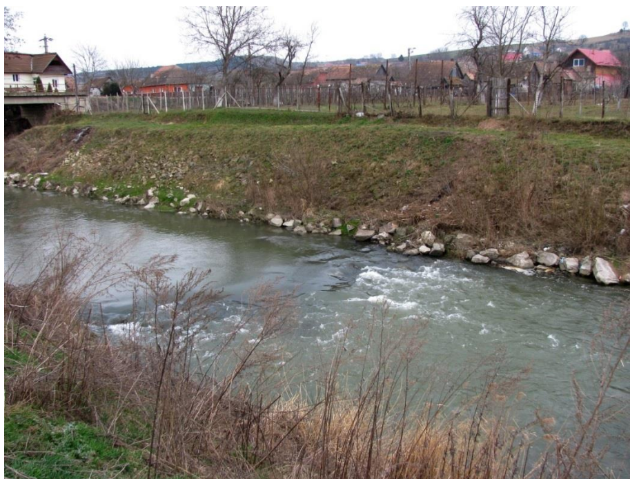
Fig. nr. 11: Prag de fund executat din anrocamente de piatră, fără utilizare de beton care asigură libera migrație a speciilor de pești.
