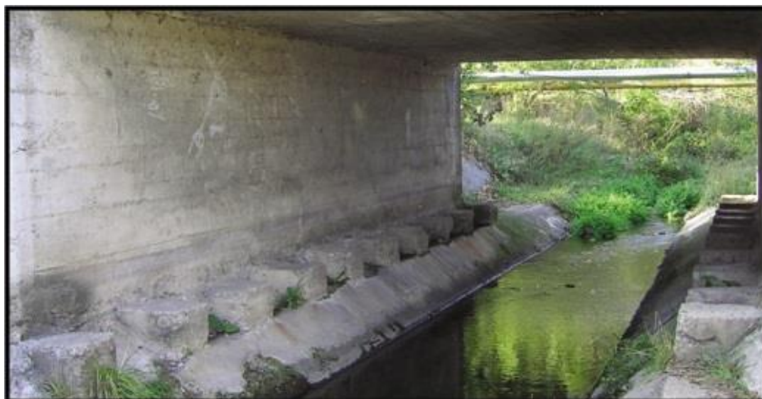
Fig. nr. 23. Pod cu bermă intermediară, favorabil
