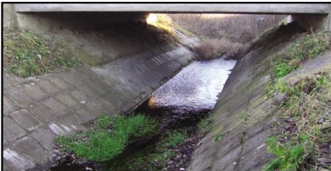
Fig. nr. 22. Pod fără bermă intermediară, nefavorabil
