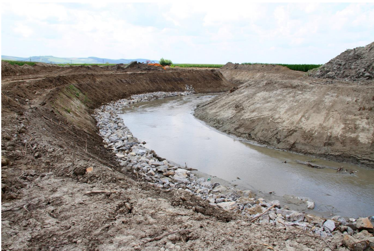
Fig. nr. 14: Îndepărtarea vegetației de pe malul unui râu în timpul executării unor lucrări de prevenire a inundației în 2015.
