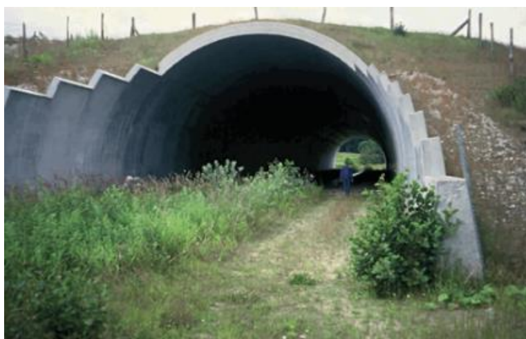
Figura nr. 8-11 Subtraversare multiplă amenajată pentru o arteră rutieră din Danemarca 38
