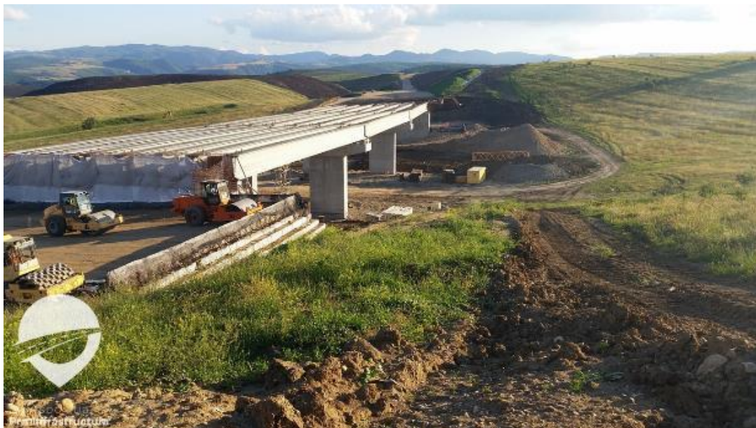
Figura nr. 5-5 Lucrări de construcție în desfășurare pe un tronson de autostradă în România 27
