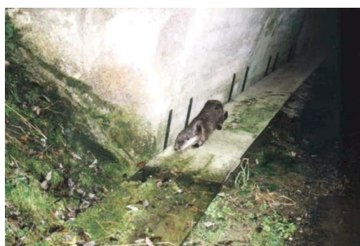
Figura nr. 8-13 Exemplu de canale modificate pentru asigurarea conectivității hidraulice dar și pentru speciile de mici dimensiuni cu deplasare terestră 40
