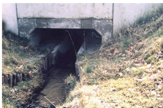
Figura nr. 8-13 Exemplu de canale modificate pentru asigurarea conectivității hidraulice dar și pentru speciile de mici dimensiuni cu deplasare terestră 40
