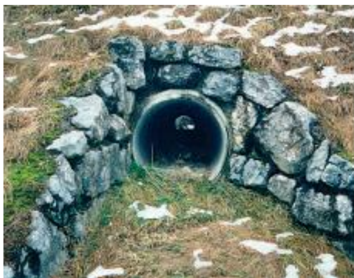
Figura nr. 8-12 Subtraversări pentru specii de animale de dimensiuni mici 39
