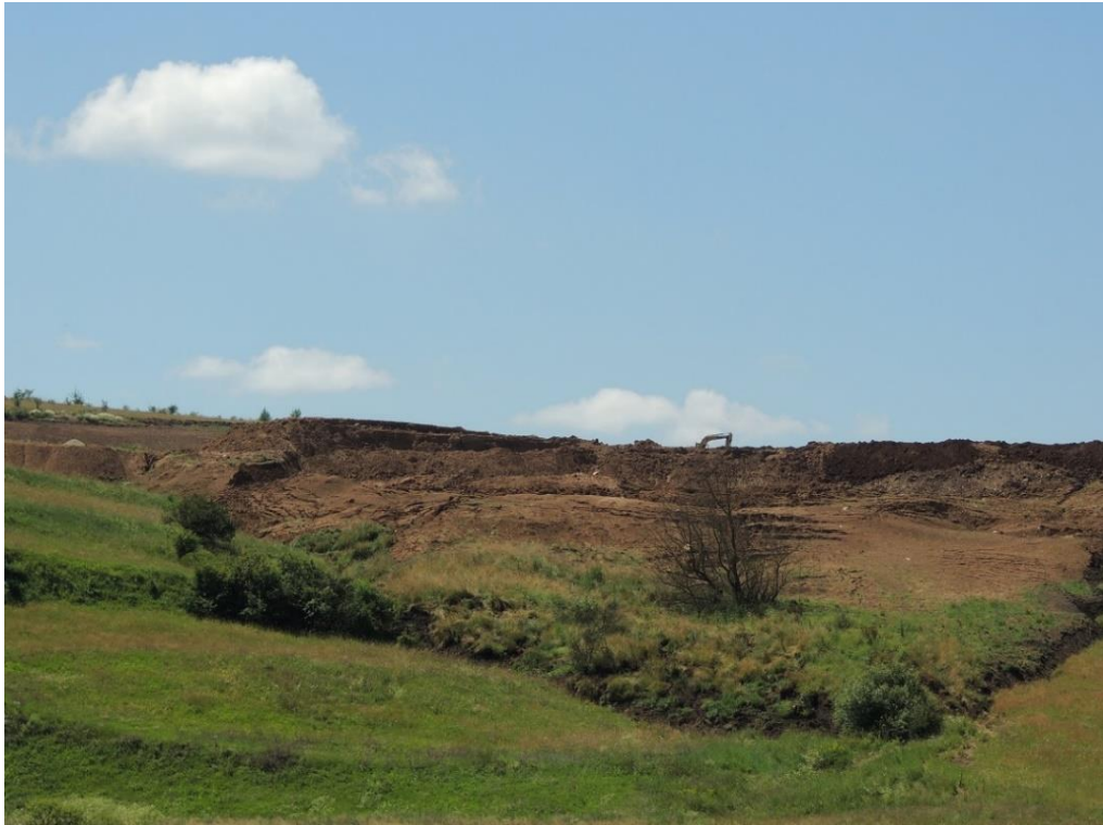
Figura nr. 4-5 Alterarea habitatelor ca urmare a alunecării unei halde de depozitare a solului excedentar (locația: Autostrada Transilvania)
