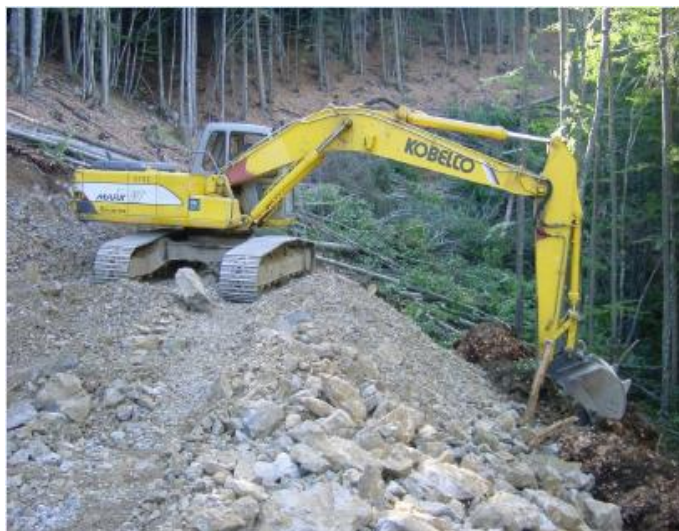
Fig.6 Excavator în lucru, cf. Ghidului de bune practici pentru drumuri forestiere
