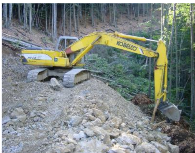
fig 3. Excavator în lucru, cf. Ghidului de bune practici pentru drumuri forestiere
