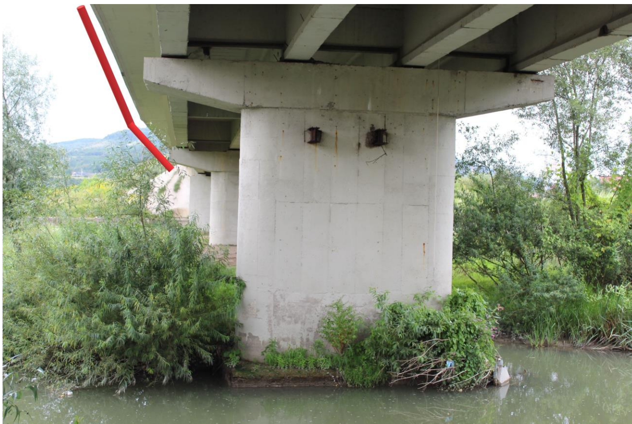
Figură 22 - Localizarea aproximativă a conductei de-a lungul podului Șieu-Măgheruș – marcajul roșu reprezintă traseul conductei (foto: Mihai Pop)
