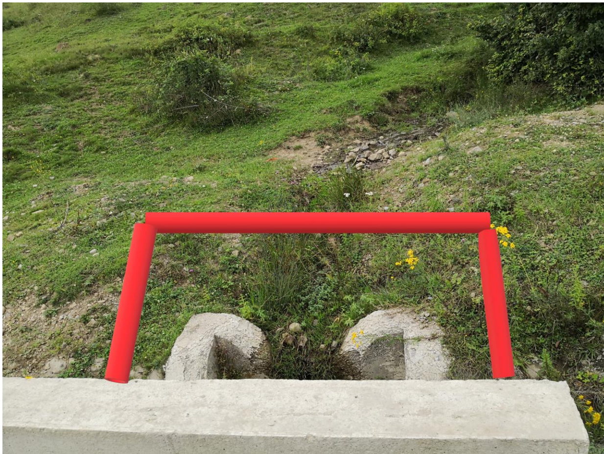
Figură 27 - Zona de subtraversare a izvorului în habitat potențial al buhaiului de baltă ( Bombina variegata ) – marcaj roșu – conducta (foto: Neațu Sabin)
