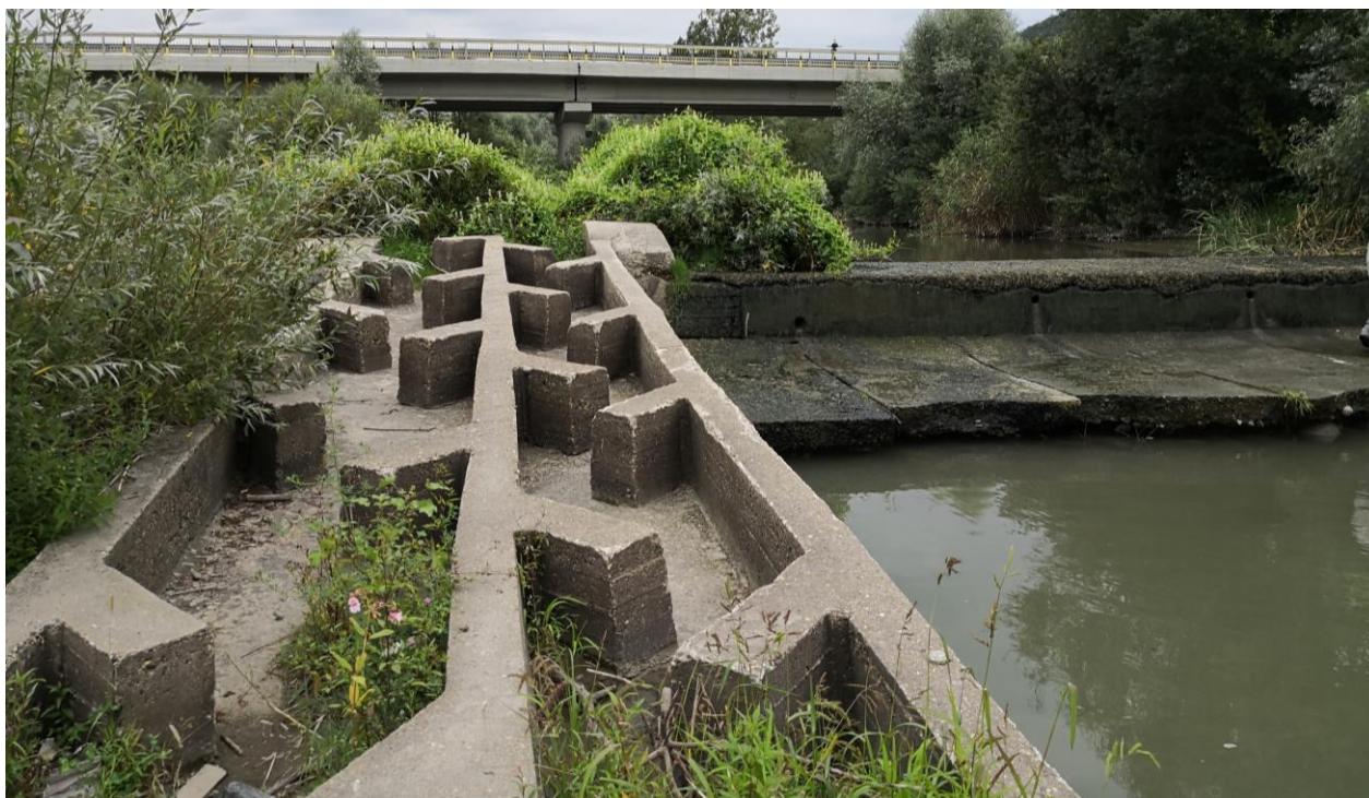
Figură 30 - Scara de pești nefuncțională și podul rutier în plan secund (foto: Neațu Sabin)
