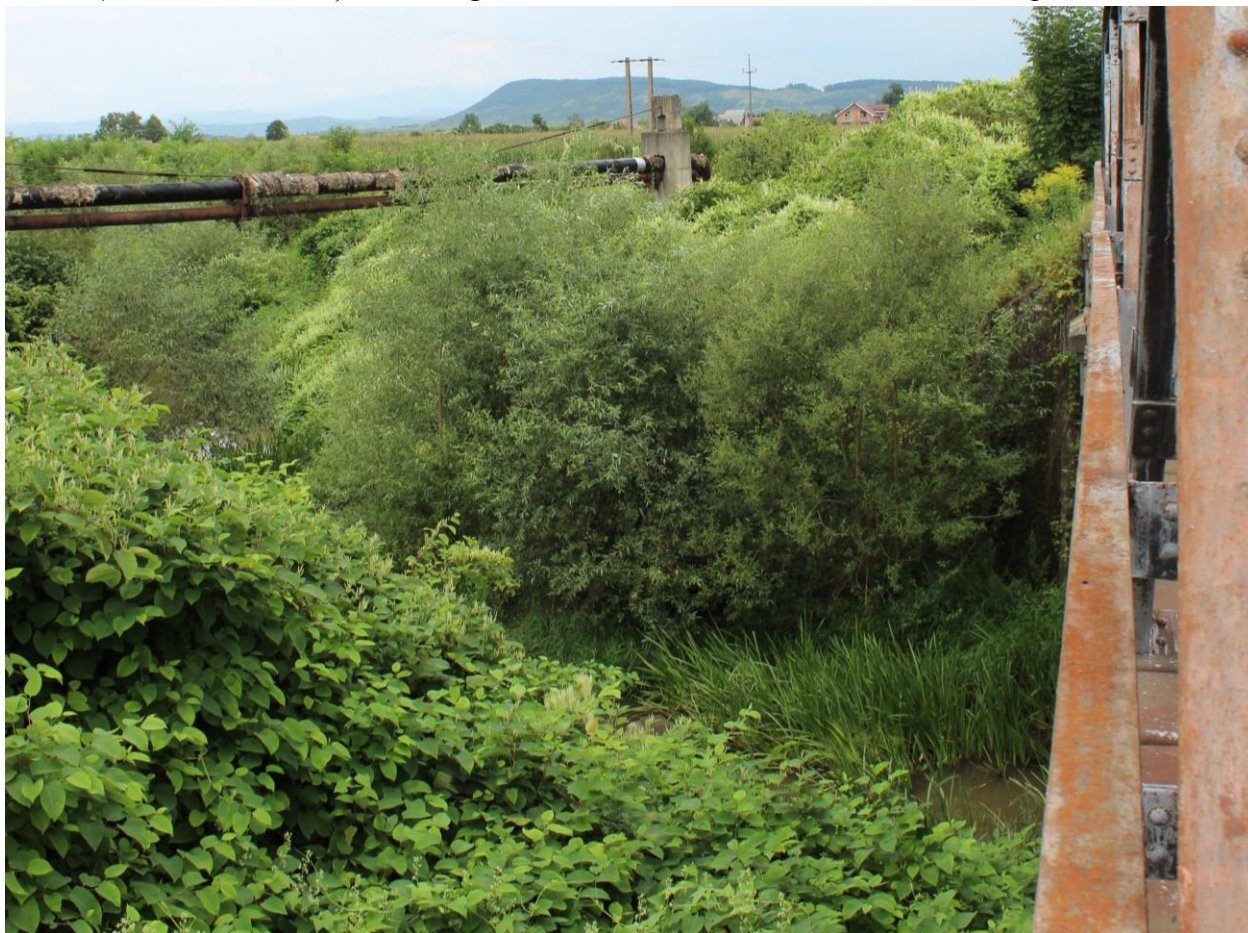
Figură 20 - Reabilitare aducțiune în zona Chirales (amplasament 1) (foto: Mihai Pop)
