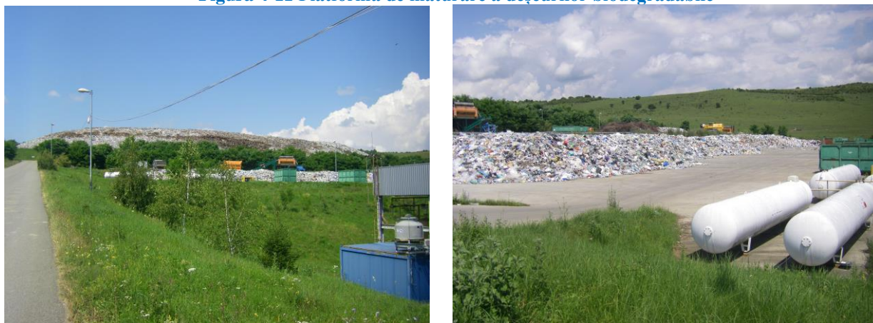
Figura 4-11 Platforma de maturare a deșeurilor biodegradabile
