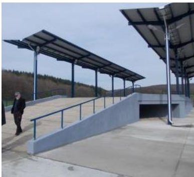
Figura 7-10 Stații deschise de transfer
