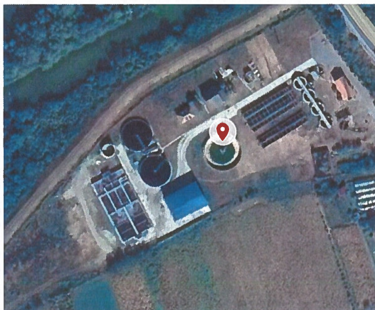
Figura 3– Vedere de ansamblu locație – Stația de Epurare BECLEAN
