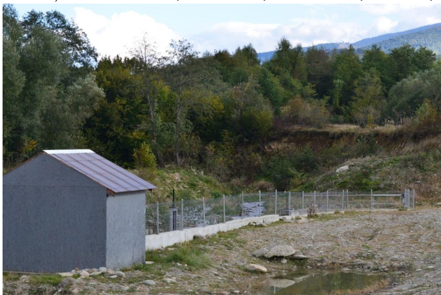
MHC Viștea existentă - Aspecte ale amplasamentului prizei de apă
