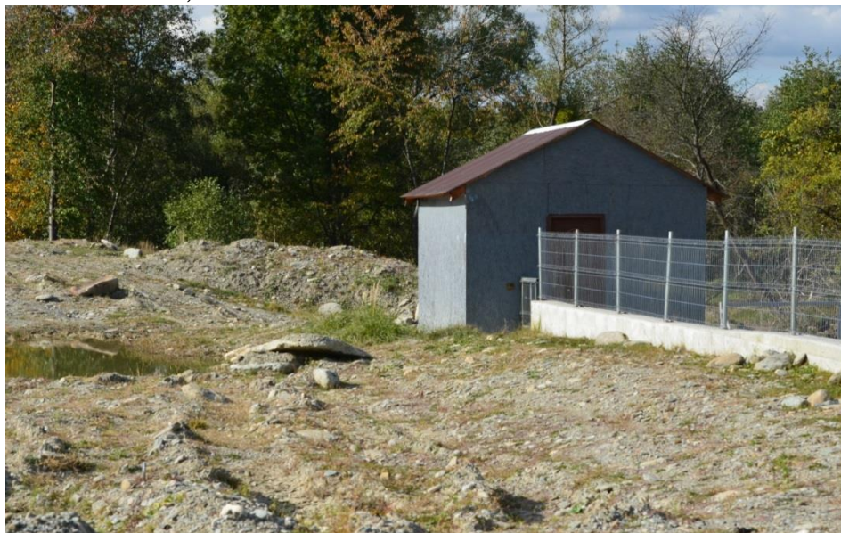
MHC Viștea existentă - Aspecte ale camerei de încărcare
