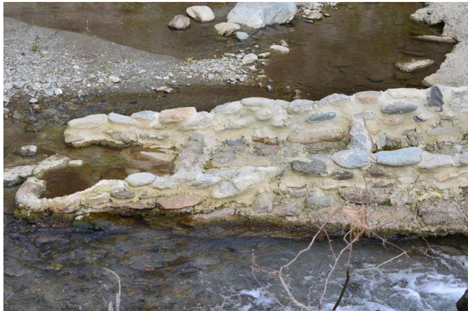
MHC Viștea existentă - Aspecte ale scării de pești
