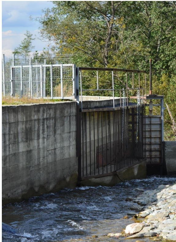
MHC Viștea existentă - Grătarul prevăzut la intrarea camerei de încărcare
