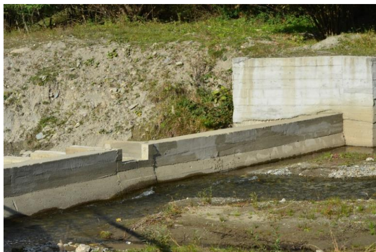
MHC Viștea existentă - Aspecte ale pragului de captare
