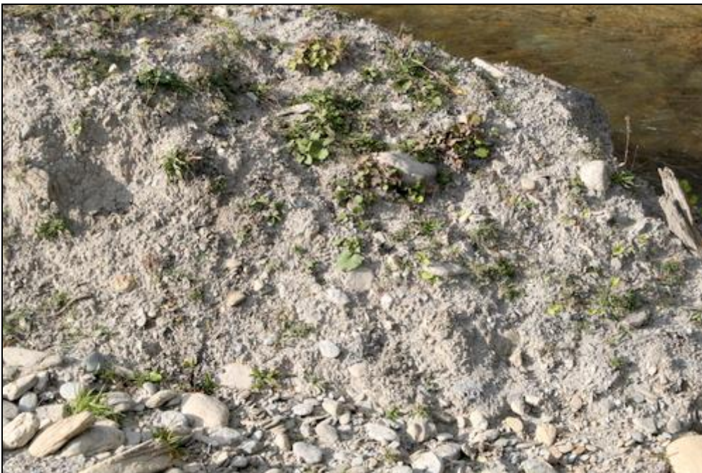
Figura nr. 30 – Aspect privind malul stâng al râului Viștea în secțiunea aferentă extremității din aval a pasajului bypass
