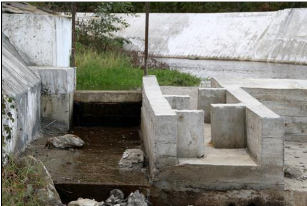
Figura nr. 19 – Aspect privind înălțimea ultimei trepte a scării de pești din pragul de captare a apei aferent păstrăvăriei de pe Viștișoara
