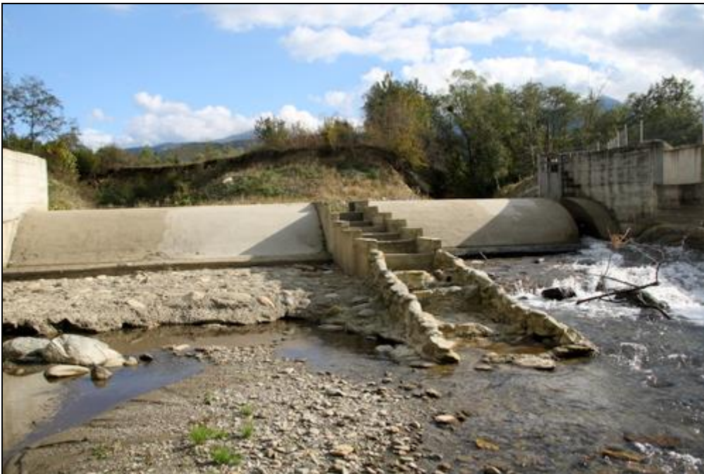
Figura nr. 3 – Aspect privind amplasarea scării de pești existente în mijlocul albiei minore a râului Viștea
