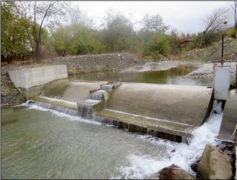
Figura nr. 1 – Aspect privind scara de pești construită inițial
