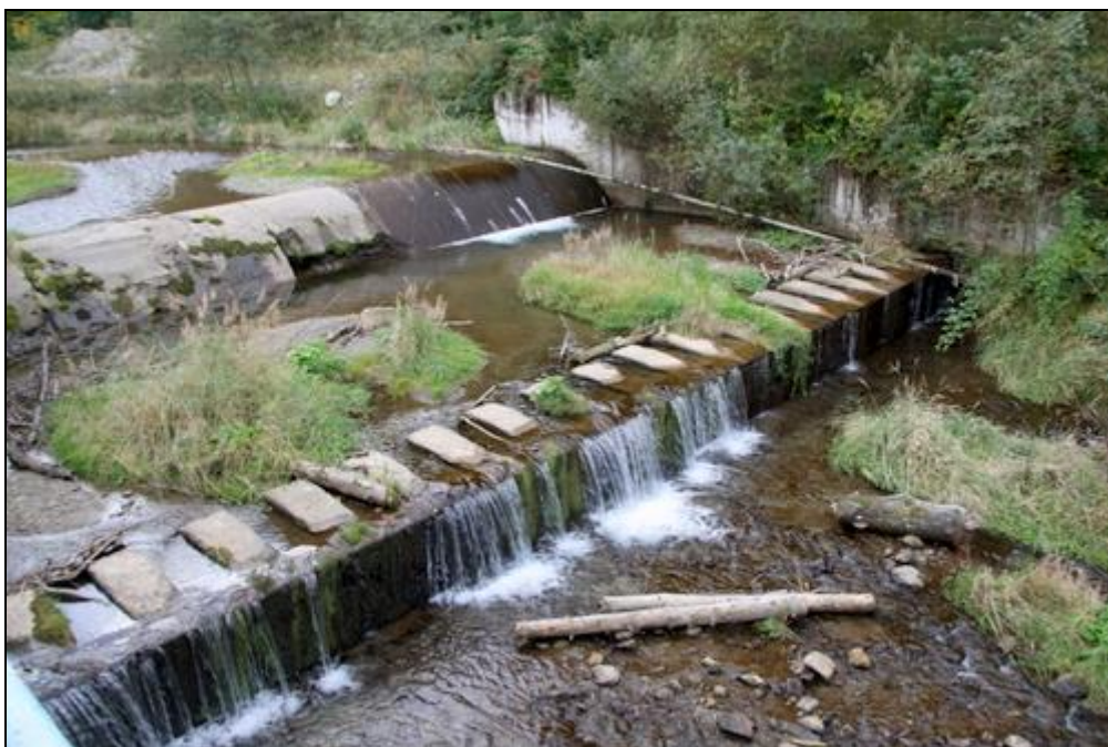
Figura nr. 23 – Aspect privind prezența a 2 praguri netranzitabile de specia Cottus gobio aferente captării de apă Viromet de pe râul Viștișoara
