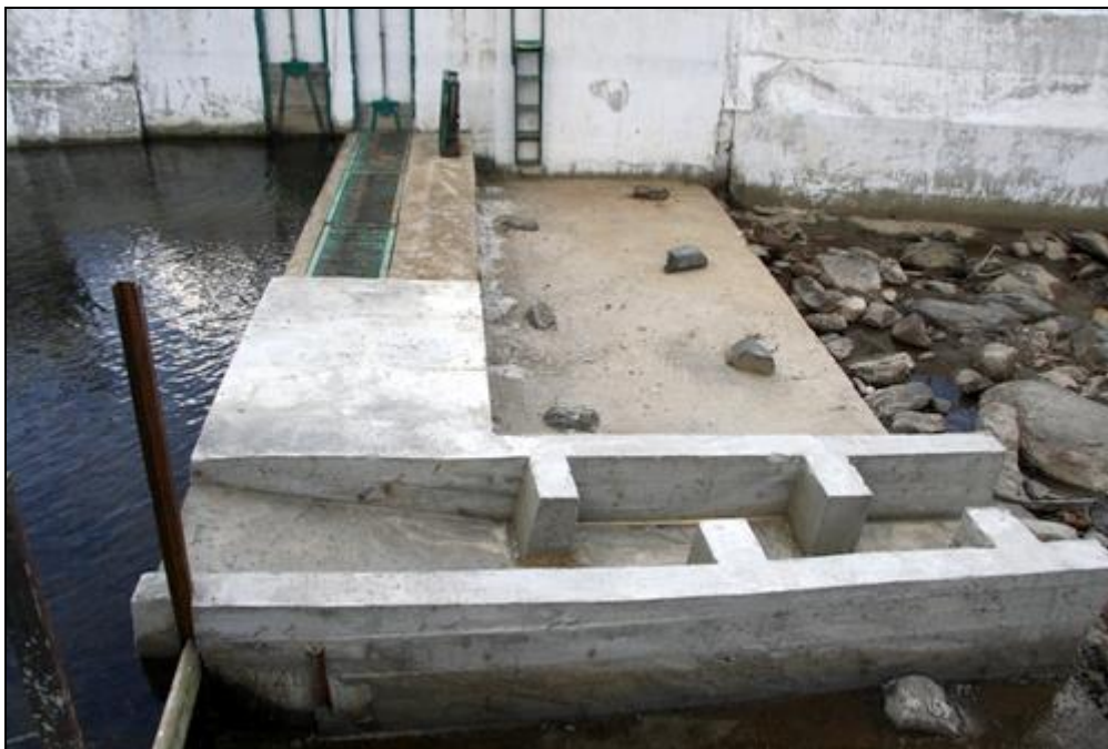
Figura nr. 18 – Aspect privind prezența unei scări de pești prin care apa nu tranzitează, amplasată în pragul de captarea a apei aferent păstrăvăriei situate pe malul stâng al râului Viștișoara, amonte de pragul de captare al proiectului analizat
