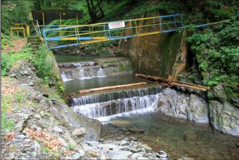
Figura nr. 16 – Aspect privind prezența unei captări Viromet pe cursul râului Viștea
