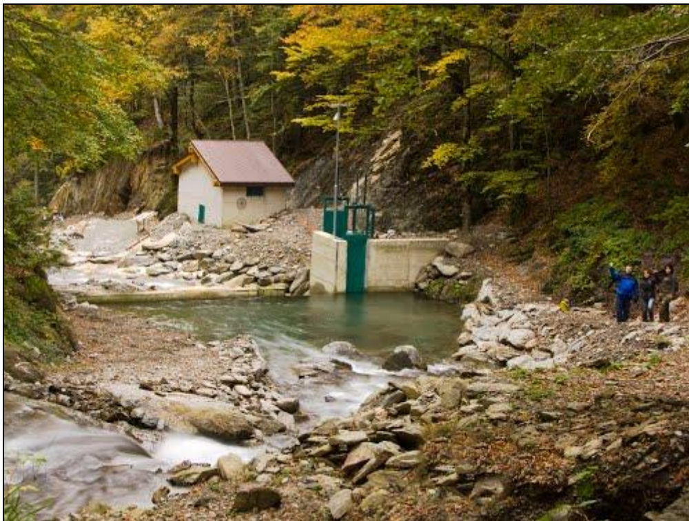
Figura nr. 24 – Aspect privind lucrările în zona de captare a microhidrocentralei de pe Viștișoara
