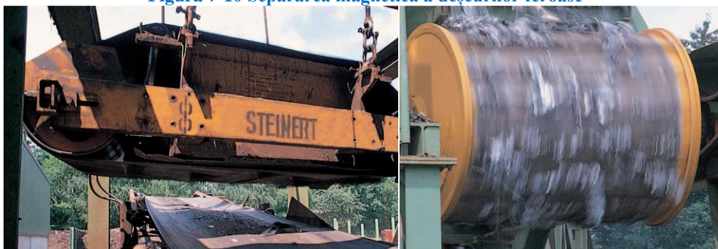
Figura 7-10 Separarea magnetică a deșeurilor feroase
