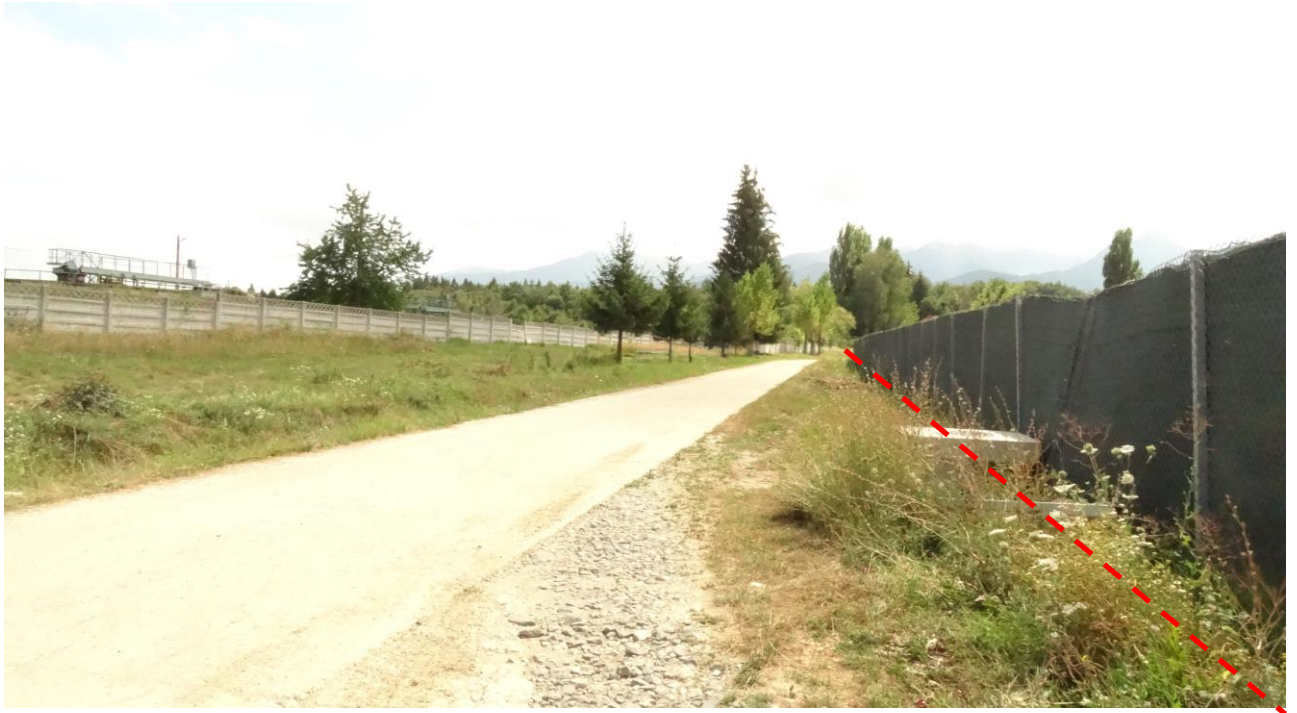
Aspect al limitei de EST cu drumul de acces la statia de epurare VIROMET
