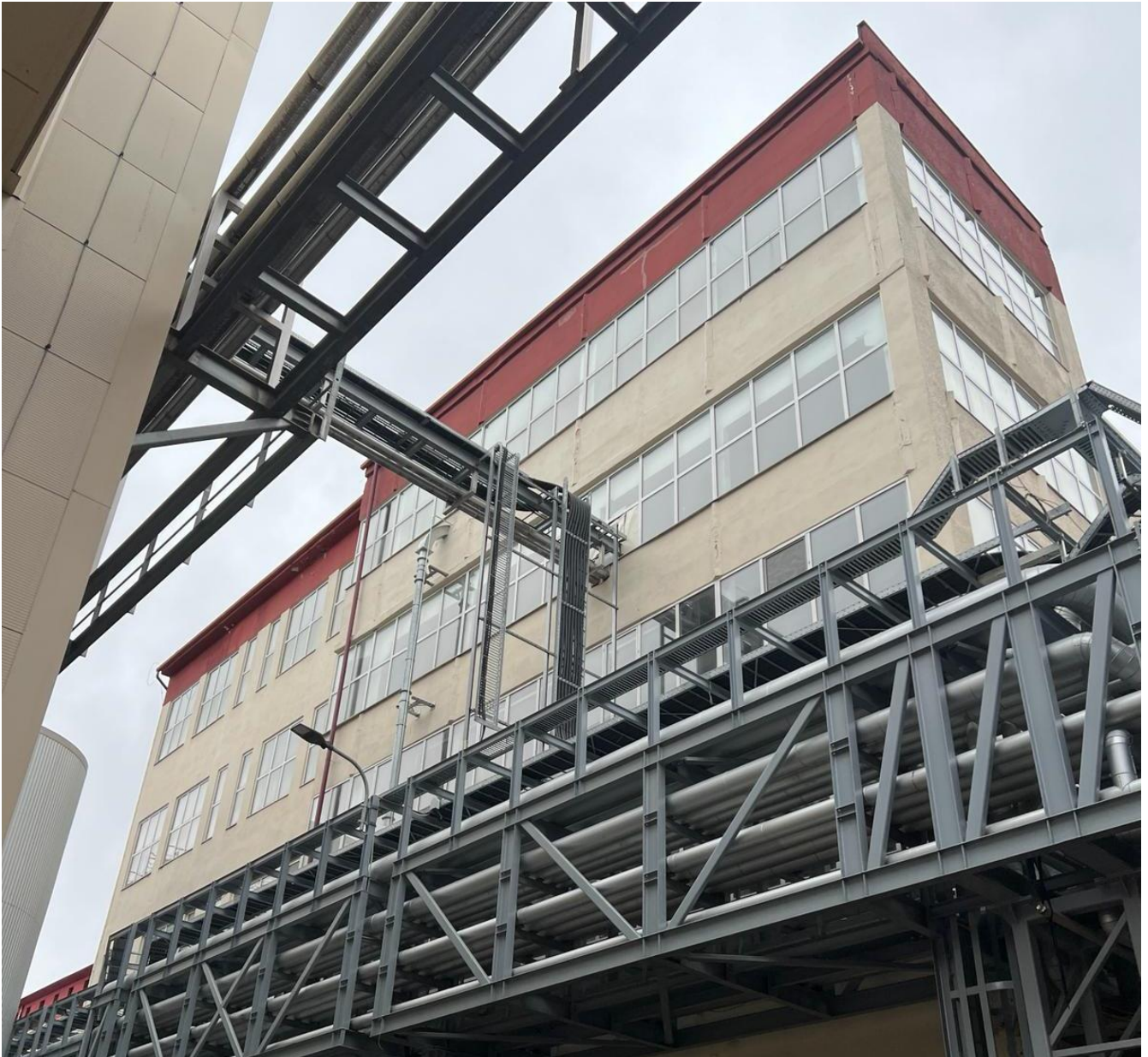
Fig. 3 – Elemente de fatada ce urmeaza a fi demontate.
