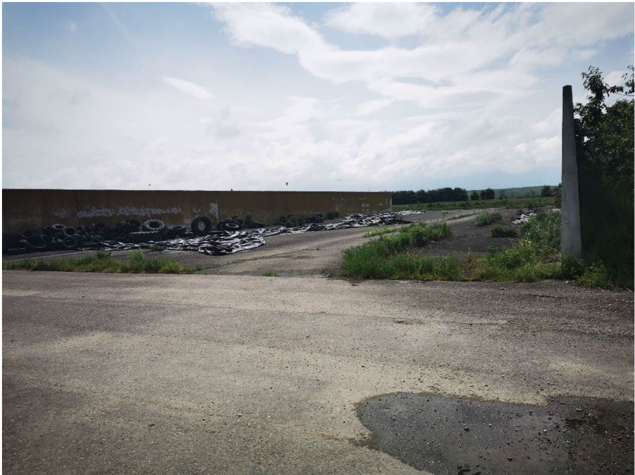
Fig.9 Platforme de insilozare și stație spălare mașini
