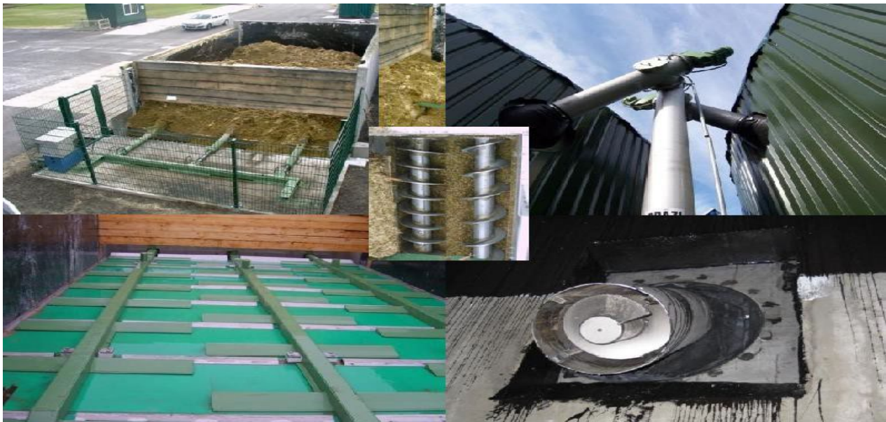
Fig. 14 Alimentarea cu substanțe solide
