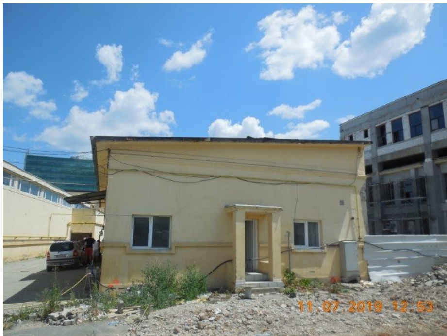
Cladirea C3 Vedere frontala
