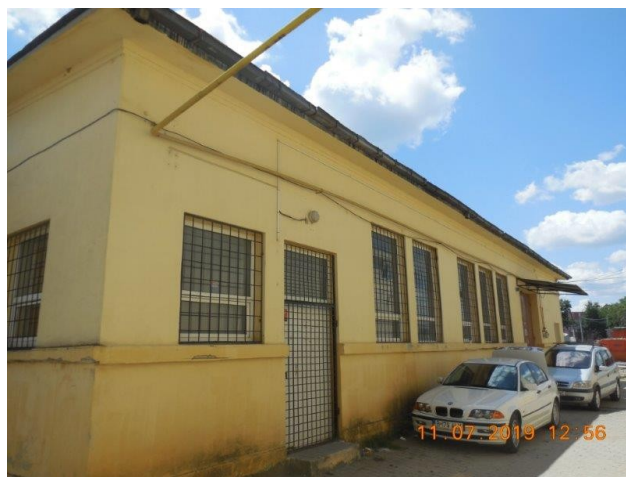
Cladirea C3 vedere laterala
