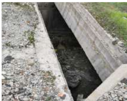
Fundatie masiva beton armat cu subsolacoperit de placa de beton
