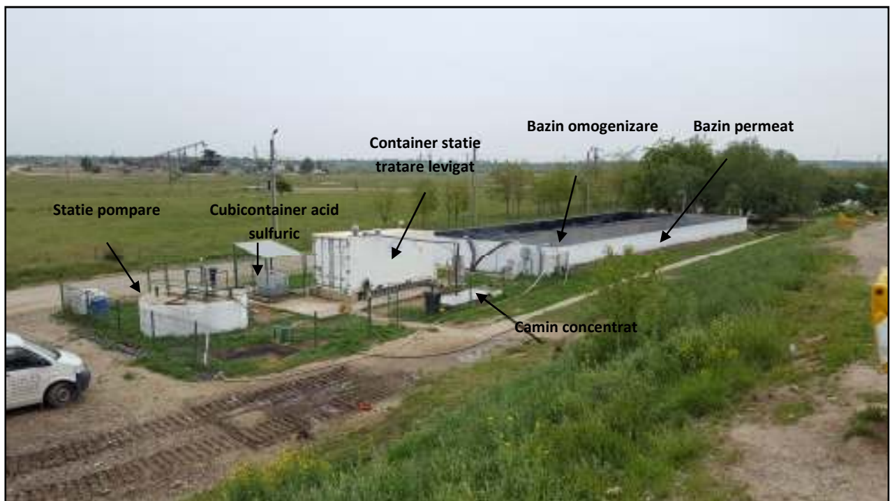
Foto 2 Amplasament stație de epurare a levigatului și obiective adiacente
