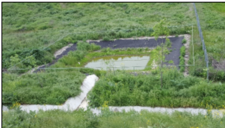
Foto 3 Bazin apa pluviala rigola perimetrala Celula 3
