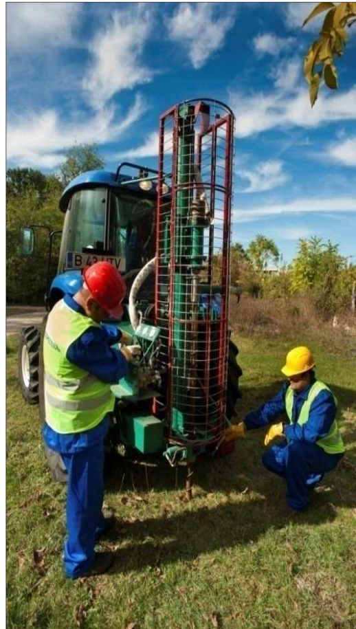
Fig.9 Realizare gaurilor cu utilaj mecanic
