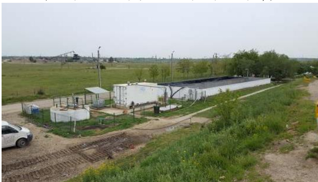
Figura 5. Amplasament Stație de epurare a levigatului.
