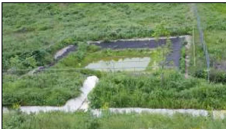
Figura 6. Bazin apă pluvială rigolă perimetrală Celula 3.
