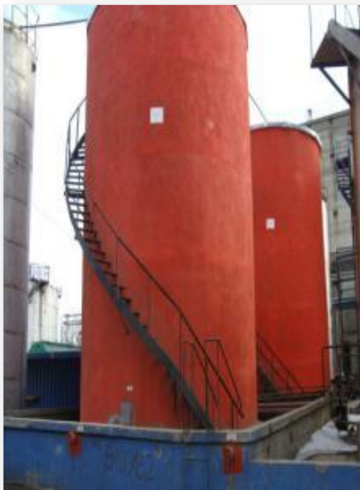
Figura 10: Rezervoare apa incendiu
