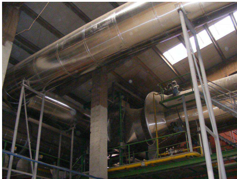
6. Izolarea conductelor de aer - recuperat
