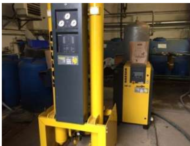
Stație de producere aer instrumental
