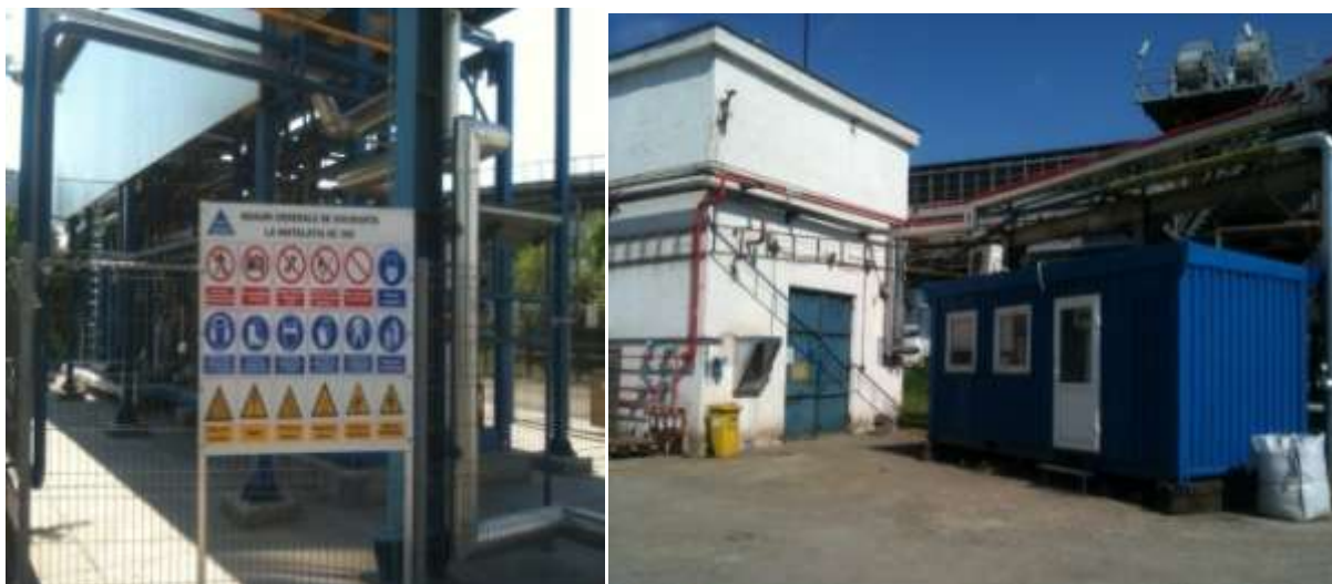
Estacada de fluide energetice și Clădire stație apă demi Werner Wilhelm (rezervă – stand by) și container destinat echipei de proiect în perioada de mentenanță (cca 200 ore/an)
