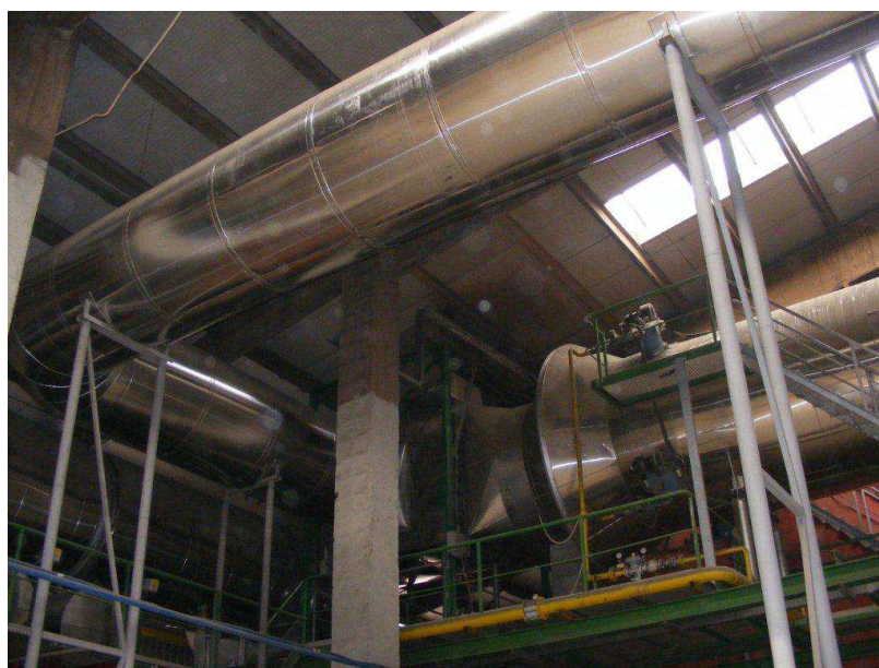
6. Izolarea conductelor de aer - recuperat
