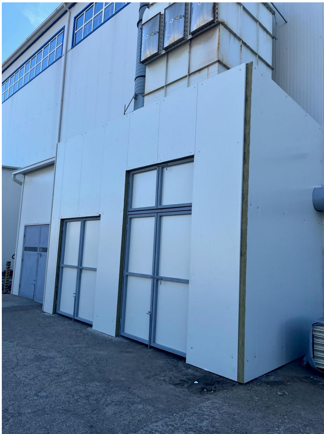
Fig. 7 Montare panouri fonoabsorbante filtru 2 premix-lucrare finalizata
