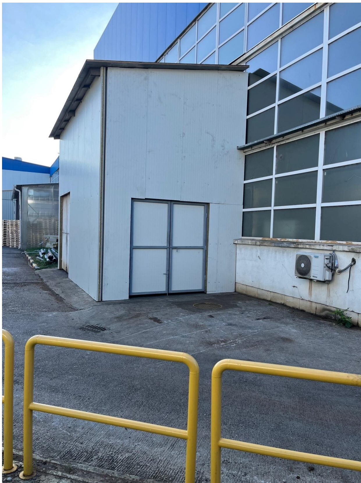
Fig. 6 Montare panouri fonoabsorbante filtru 1 Sult –lucrare finalizata
