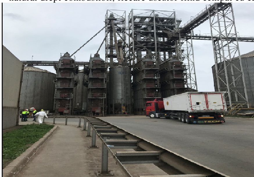
Figură 28: bateria veche de uscătoare
