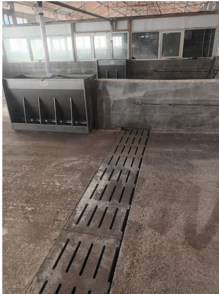
Fig.12 - Hranitoare dubla (Hala H6)
