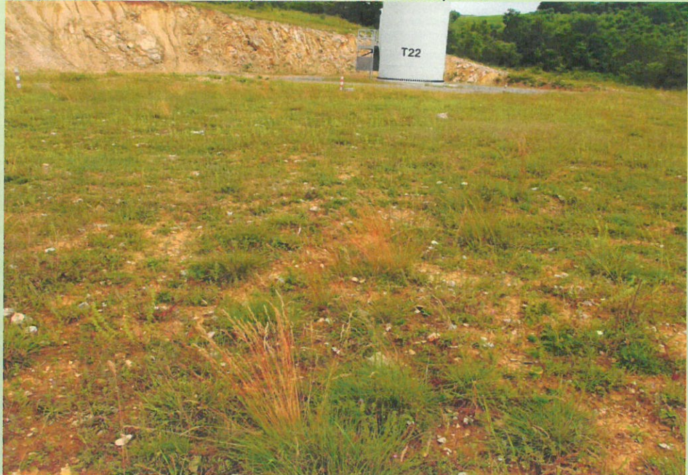
Figura 37. Aspect al covorului vegetal instalat pe platforma tehnologică a turbinei T22 (foto: Mihaela Urziceanu, iunie 2016)
