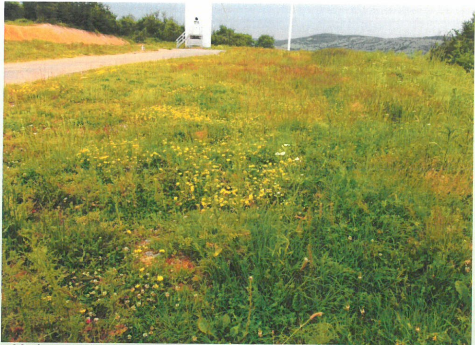
Figura 26. Aspect al covorului vegetal instalat pe platforma tehnologică a turbinei T11 (foto: Mihaela Urziceanu, iunie 2016)
