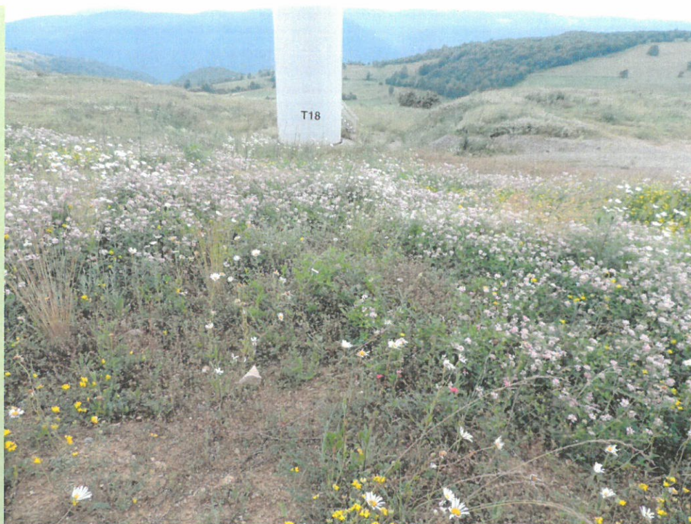
Figura 33. Aspect al covorului vegetal instalat pe platforma tehnologică a turbinei T18 (foto: Mihaela Urziceanu, iunie 2016)
