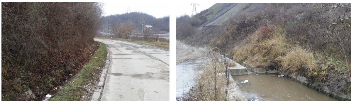
Foto 2 și 3: rigola pe latura estică și nord-estică și preluare ape pluviale în bazin decantor înainte de trecere în emisar, valea Țerova
