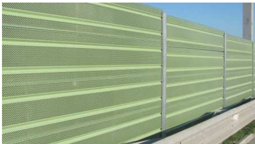
Img. 1 Gard din panouri fonoabsorbante
