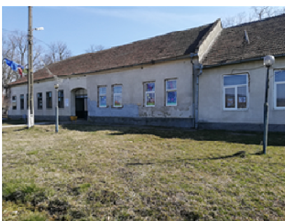
Clădire școală și gradinița Fizeș
