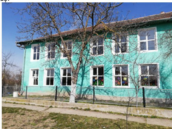
Clădire școală și gradinița Ghertenis
