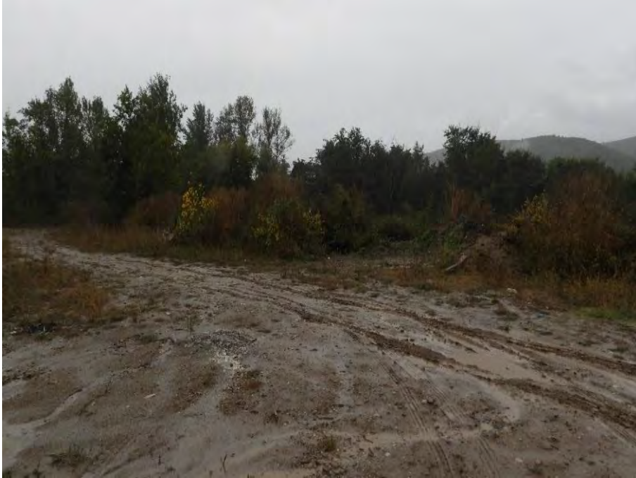
Foto 26. Aspectul amplasamentului stației 18
