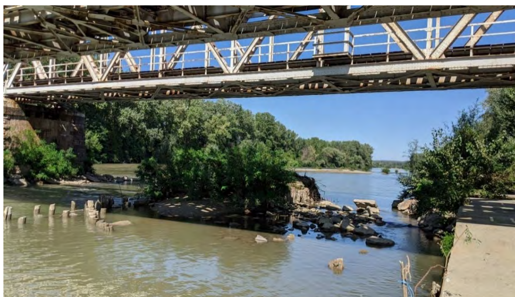
Foto 82. Aspectul râului Jiu la km 291+000
