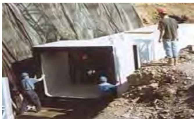
Figura - Exemplu de podeț din elemente prefabricate, în faza de execuție
