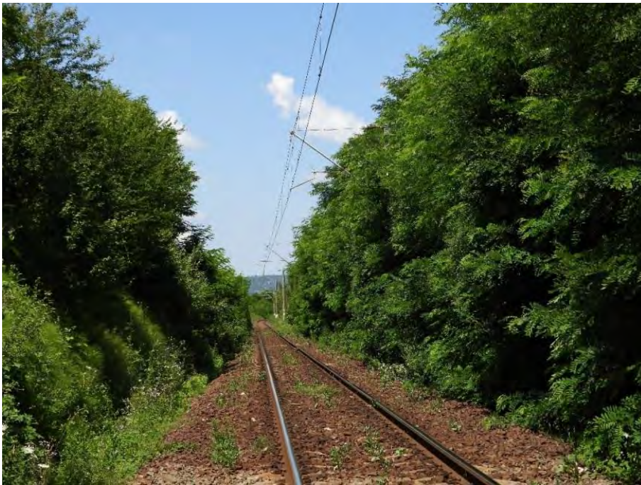
Foto 27. Aspectul amplasamentului stației 19
