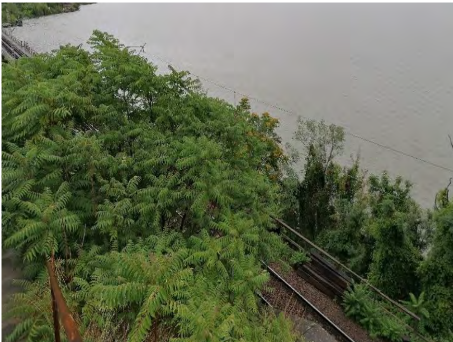
Foto 21. Aspect general al vegetației
