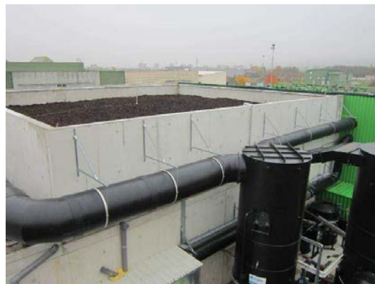
Fig. 18. Purificator - Biofiltru
