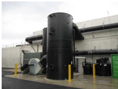
Fig. 19. Biofiltru
