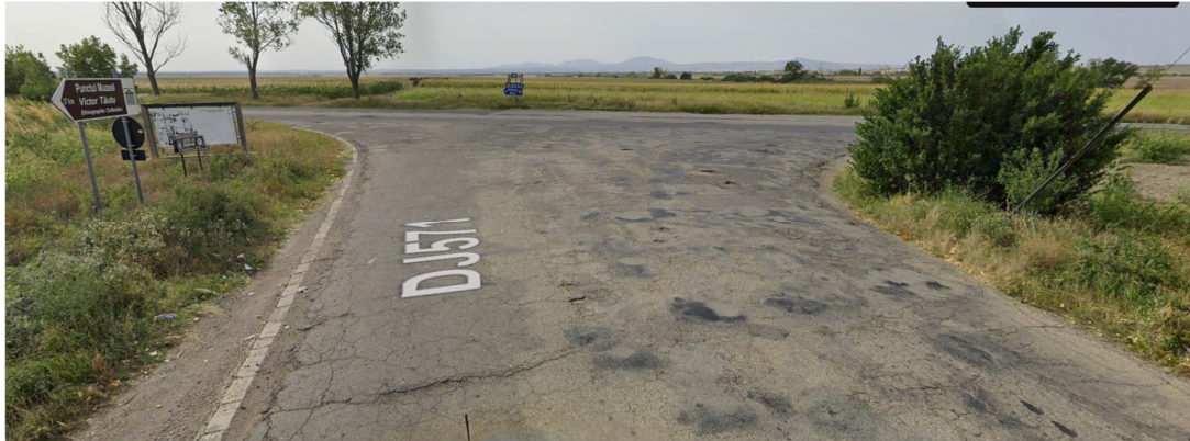
Foto: zona de sfarsit proiect – intersectie DJ571 – DN57 - Ciuchici
