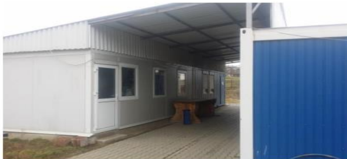
Model de organizare de șantier realizată din containere mobile
