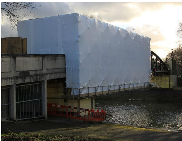
Fig: un exemplu de incinta de protecție pentru sablare și vopsire
