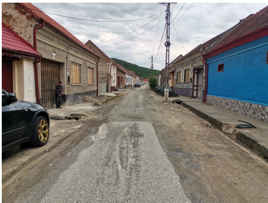
Fig. 3 Situația existentă strada 3
