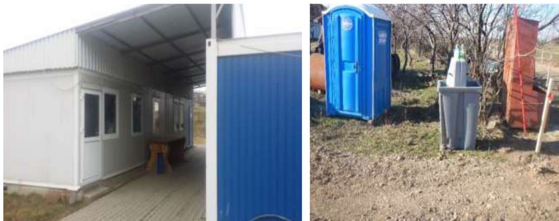
Fig. 5 Soluție de amenajare containere modulare Sisteme modulare: toaletă individuală, chiuvetă modulară; pichet PSI
