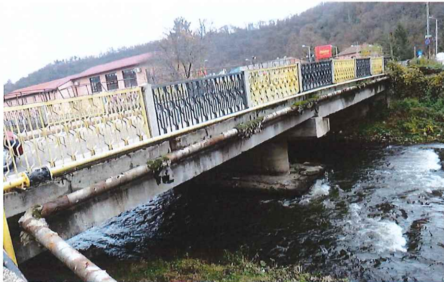
Vedere laterală amonte
