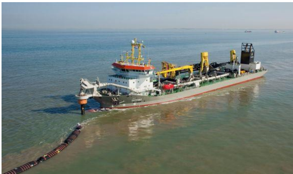
Fig. 10. Pompare la țărm prin conductă ( https://www.dredgepoint.org )
