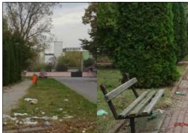
Fig. nr. 3.42 Spații verzi degradate: Str. Ana Ipătescu și parcul de la intersecția ei cu Str. Depozitelor
