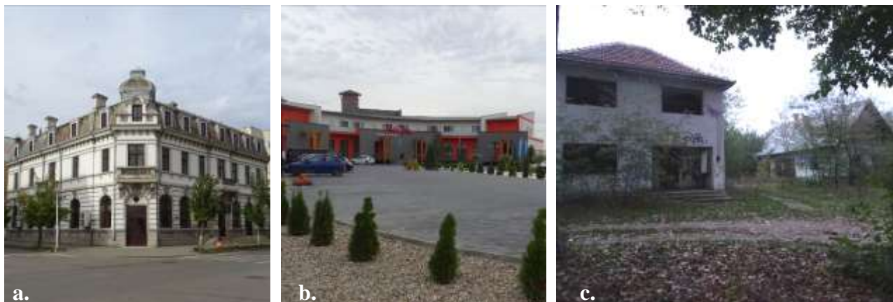
Fig. nr. 3.31 Aspecte ale infrastructurii de cazare turistică (anterior funcțională, în funcțiune sau cu posibilități de reabilitare) a municipiului Băilești: a. Hotel Turist , b. Royal Hotel & Events , c. fostul sat de vacanță din pădurea de salcâm situată la sud de Balta Cilieni
