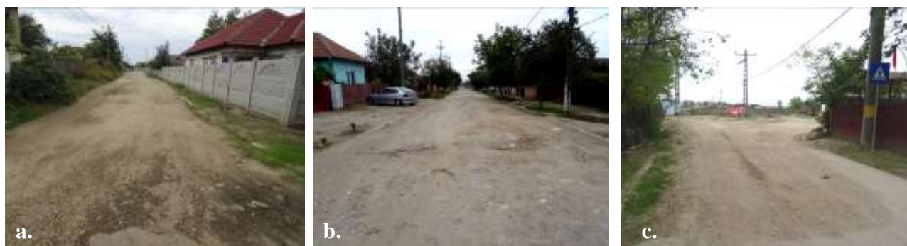
Fig. nr. 3.49 Exemple de elemente ce necesită reabilitare în cadrul infrastructurii rutiere și conexe (străzi, spații pietonale și verzi, semnalizări neconcordante cu marcajele): a. Str. Speranței, b. Str. A.I. Cuza (est), c. Intersecția Str. Meseriașilor și Viilor
