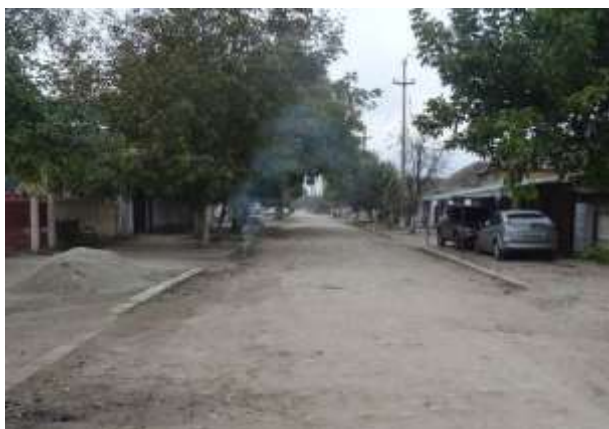
Fig. nr. 3.50 Infrastructură precară și circulație pietonală stânjenită de garaj improvizat pe trotuar și spațiul verde (Str. A. I. Cuza)
