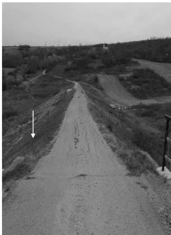
Figura 3: Barajul Dumbrava-Rocsoreni (Sursa: Raport Expertiza Tehnica, anul 2018)
