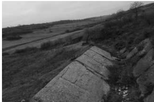
Figura 5 Descarcatorul de ape mari in zona canalului de evacuare (Sursa: Raport Expertiza Tehnica, anul 2018)
