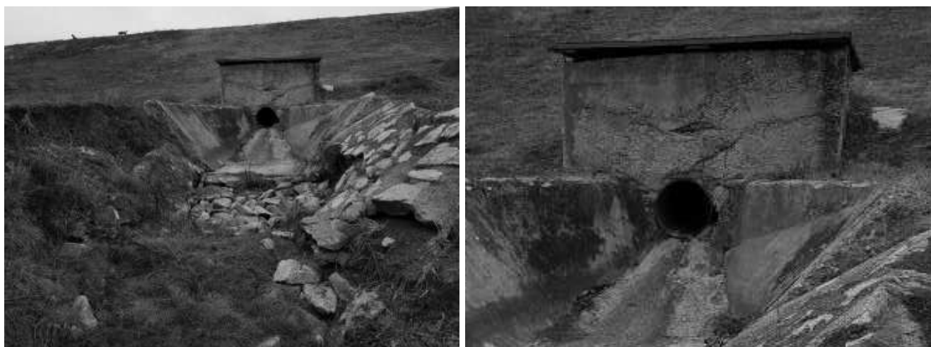
Figura 9: Iesirea din cadrul conductei golirii de fund, partea aval (Sursa: Raport Expertiza Tehnica, anul 2018)
