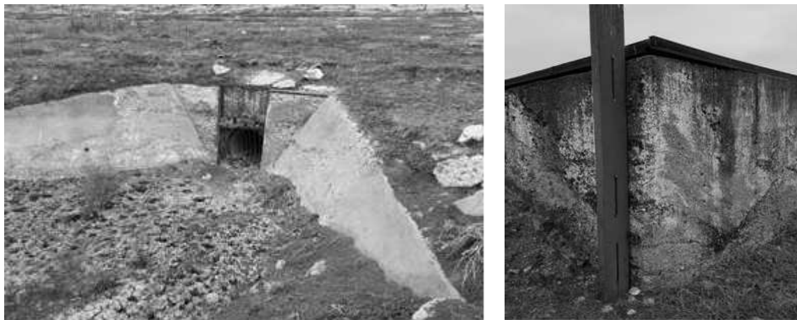
Figura 8: Golirea de fund, partea amonte si calugarul golirii (Sursa: Raport Expertiza Tehnica, anul 2018, anul 2018)
