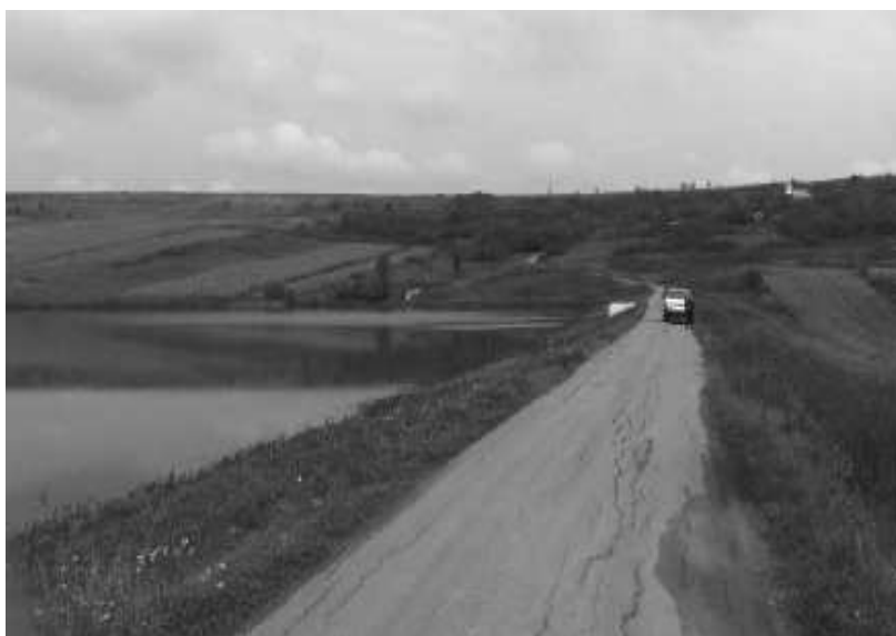
Figura 2: Coronamentul barajului, traversat de DJ83A (Sursa: Raport Expertiza Tehnica, anul 2018)
