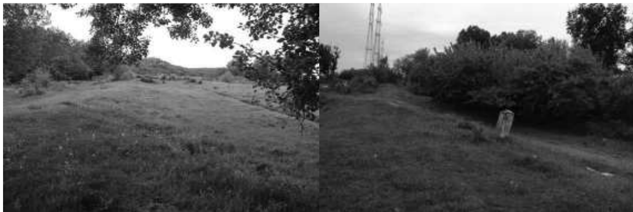
Figura 16 Zone cu denivelari ale coronamentului, dar cu latimi variabile (Sursa: Raport Expertiza Tehnica, 2018)
