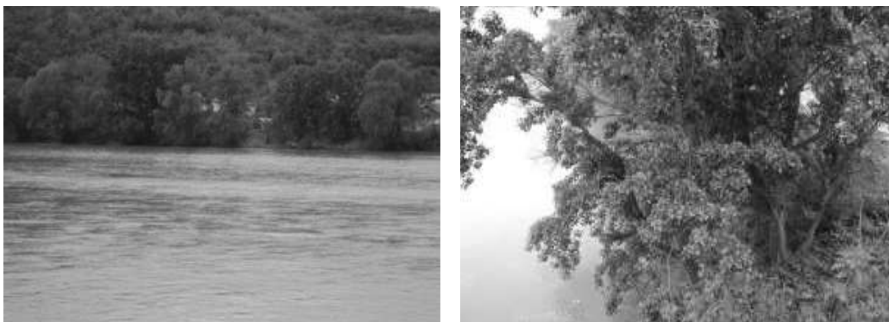
Figura 14: Eroziunile de mal care se apropie de diguri, aval pod Bucovat (Sursa: Raport Expertiza Tehnica, anul 2018)
