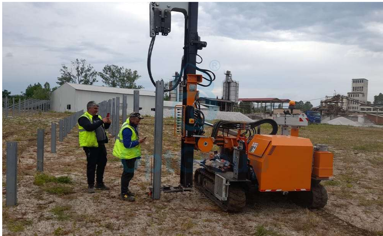
Figura 7 – Exemplu de fixare a structurii metalice in sol prin batere cu utilaj specializat.
