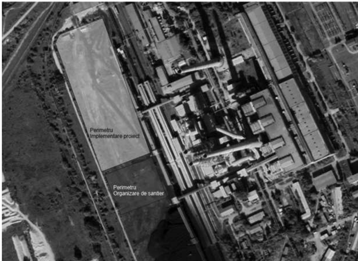
Figura 5. Aspectul platformei tehnologice de la nivelul proiectului unde urmează a se realiza investiția; se pot observa platformele și spațiile industriale generoase ce pot asigura funcțiunile de organizare a șantierului, inclusiv baracamente acoperite
