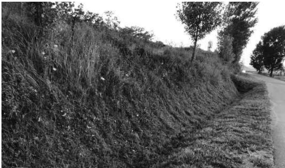
Figura 14. Rigolă înierbată din proximitatea unei căi de acces betonate
