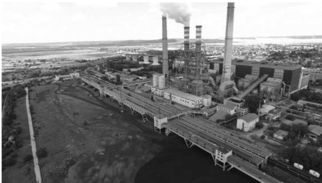
Figura 4. Structurile de tip industrial ce domină peisajul de la nivelul zonei studiate
