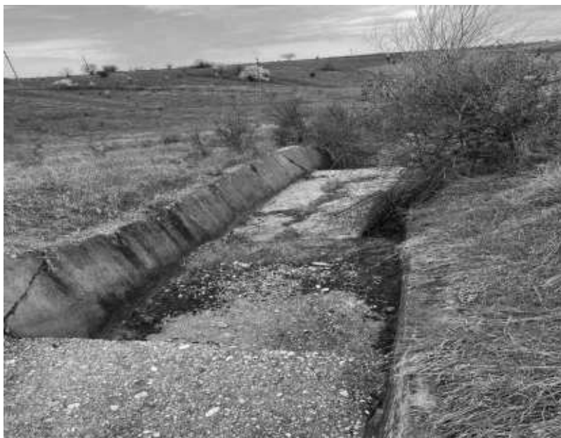
Canal de evacuare preaplin al lacului Ghercești Baraj
