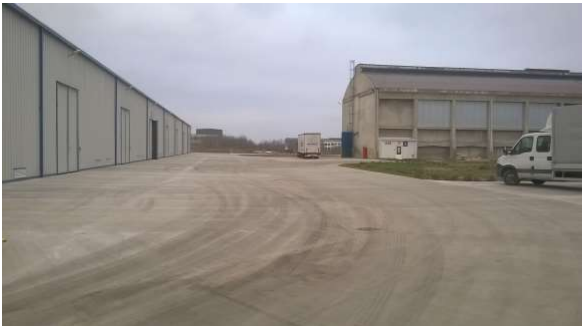
Foto nr.1 Vedere spre amplasamentul depozitului de ingrasaminte chimice, Hale existente C3 din beton si C8 cu invelitoare metalica
