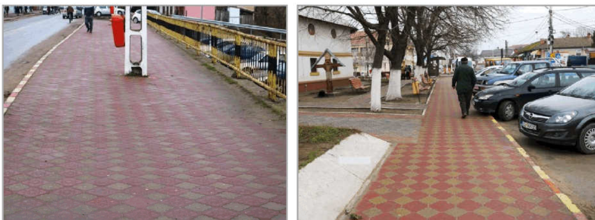
Figura 2.43. Trotuare modernizate (Exemplificare).
