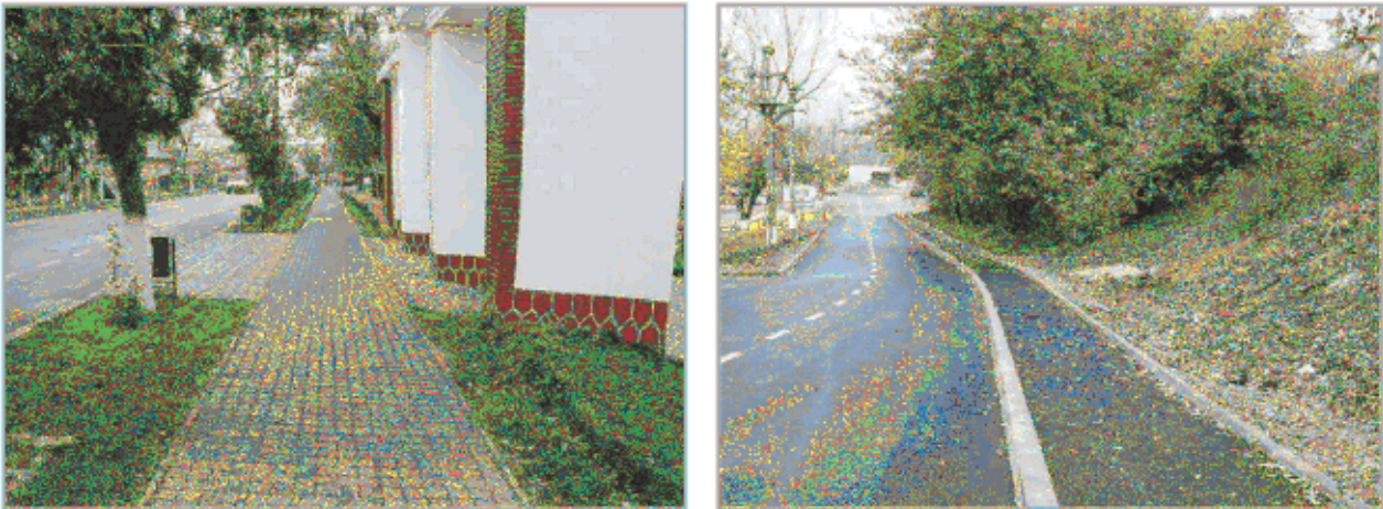
Figura 2.49. Trotuare modernizate (Exemplificare).
